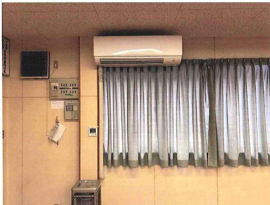
下田頭くじば公会堂 エアコン改修
