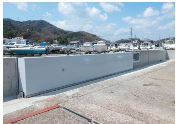
[ 海岸保全施設整備写真 ]
