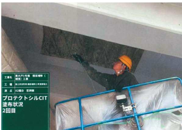
[ 道路橋梁修繕状況写真 ]
