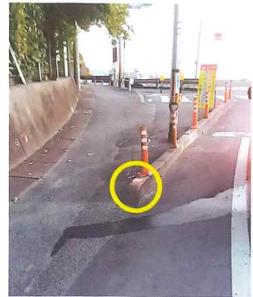
視線誘導マーカ―（鉄南）
