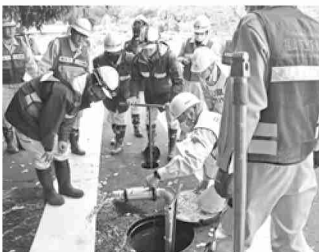
福山市の水道水を緊急時連絡管を通して笠岡市に配水
