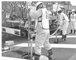
福山市から送られた水道水を笠岡市側で笠岡市の給水車に注水
