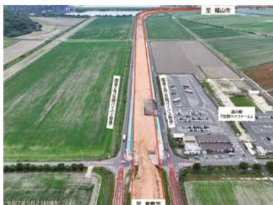
新神島大橋から道の駅に向けて安全な道路造りのため、軟弱地盤対策として地盤の強度増加を図る必要があり、段階的に盛土を行いながら慎重に進めています。
