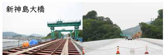
新神島大橋では、橋長380mのうち、256mの架設が完了しています。順調に進捗すれば、秋頃には架設が完了する見込みです。
