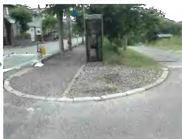
縁石の設置補修完了
