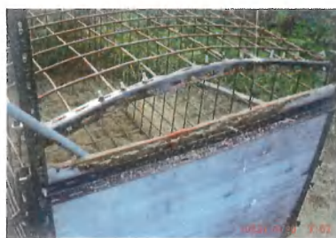
罠の損傷 L字バー変形
