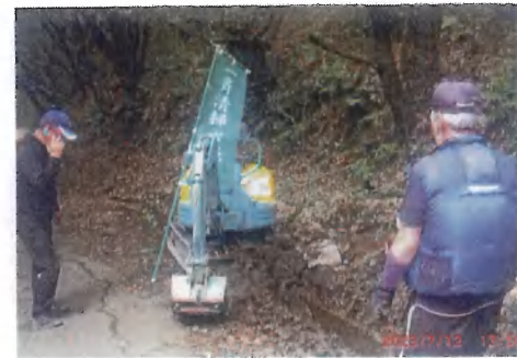
豊浦峠 側溝の整備、重機が大活躍してくれました。
