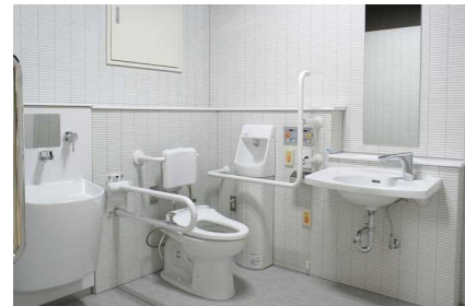
○多目的トイレの設置
