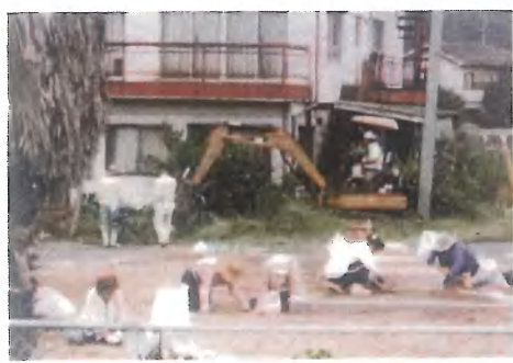
お旅所付近 雑木は重機で処理して頂きました。
