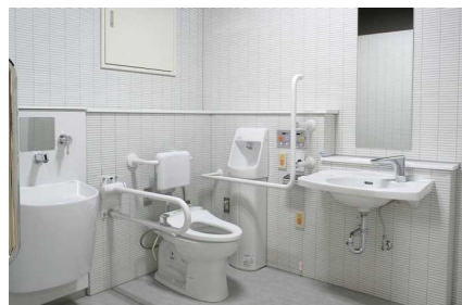
○多目的トイレの設置
