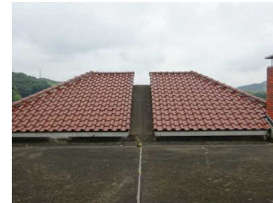
北棟屋上屋根
