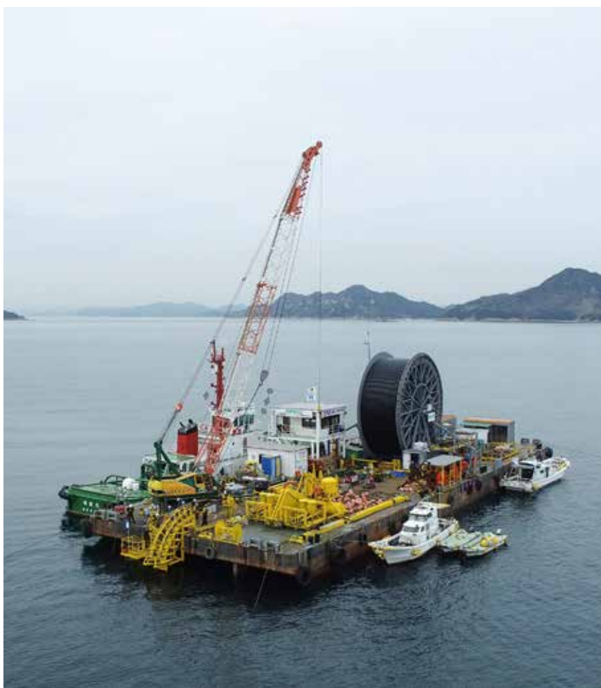
海底送水管敷設作業
