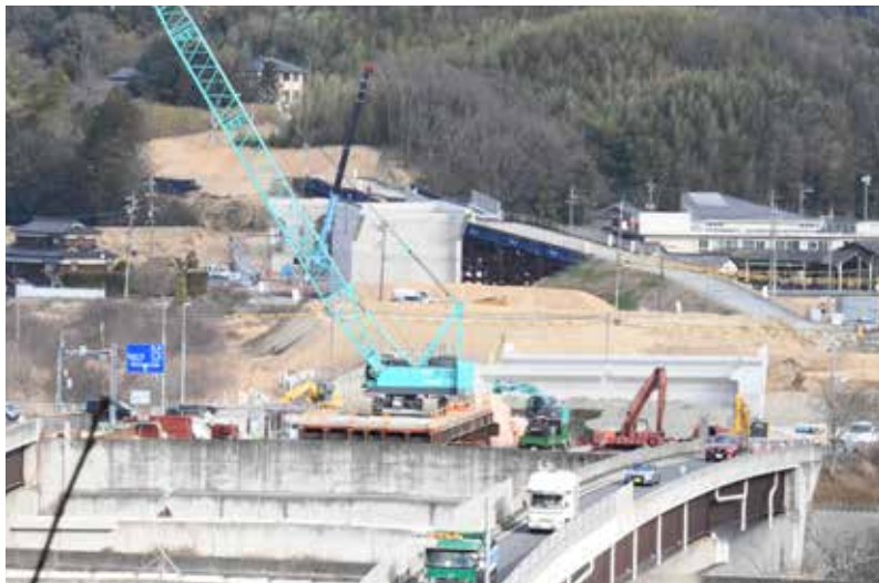
国道2号バイパス 玉島・笠岡道路 建設工事
