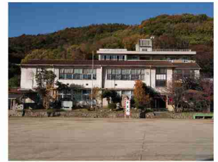
旧大島東小学校 (現・シェアアトリエ海の校舎)
