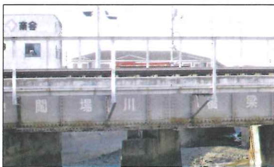
山陽本線の鉄橋に「閻場川橋梁」とある
