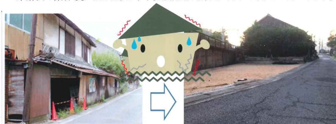
【金浦鉄北地区空き家撤去の一例】
