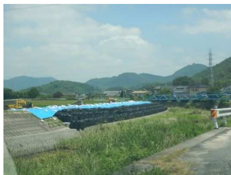
7 月豪雨被害による堤防改修（尾坂川）
