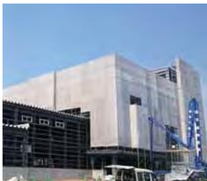
建設中の新本社工場
