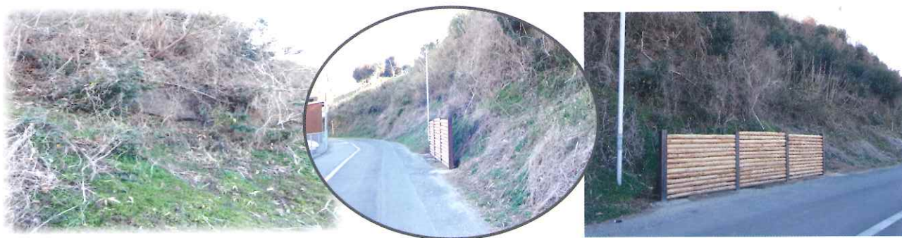
【新川～当摩地区市道の落石危険個所に落石止め柵設置(笠岡学園のご協力による)】
