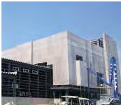
建設中の新本社工場
