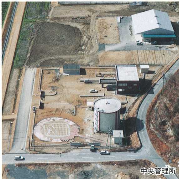
金崎分水塔周辺
