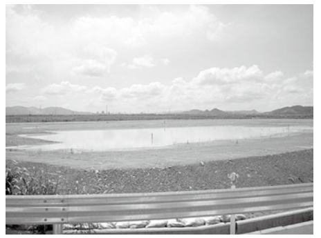
道の駅建設地
