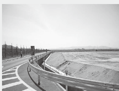
道の駅建設地
