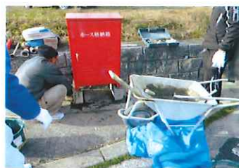
(取替え作業風景)
