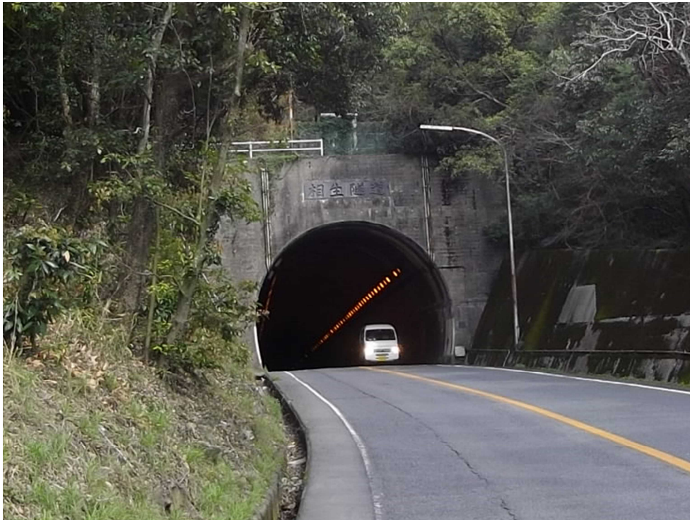
相生トンネル
