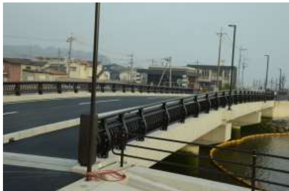
隅田川1号橋の下部工及び上部工が完成(12月)
