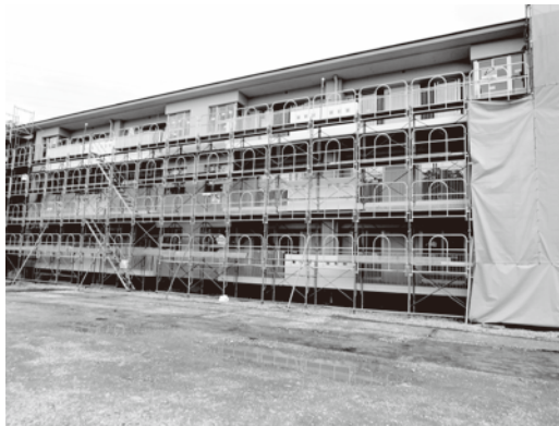
建設中の子育て支援住宅
